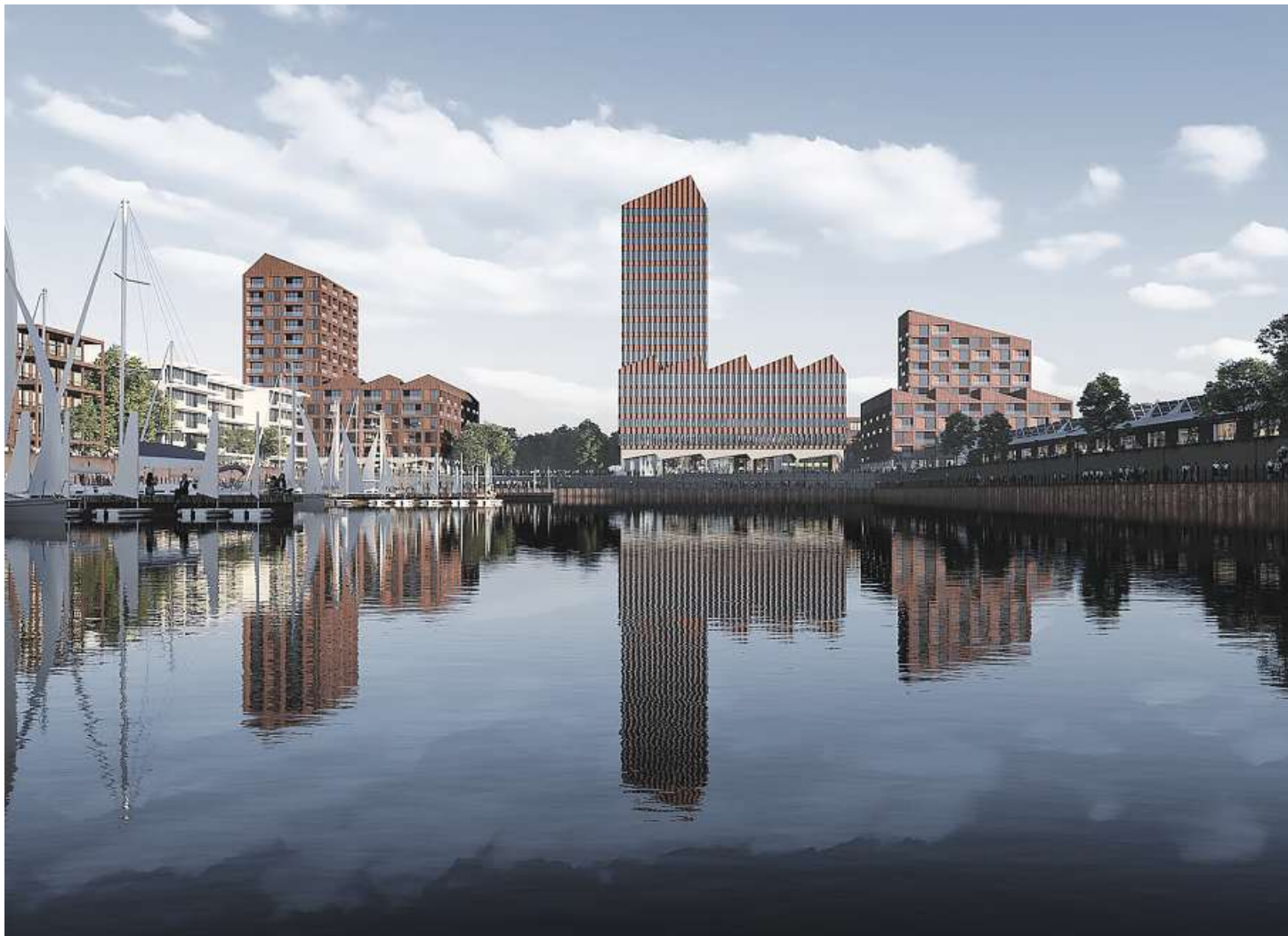
Wunderschöne 338 Mietwohnungen mit besonderem Lebensgefühl warten auf neue Mieter. ILLUSTRATION: GUSTAV ZECH STIFTUNG MANAGEMENT GMBH
